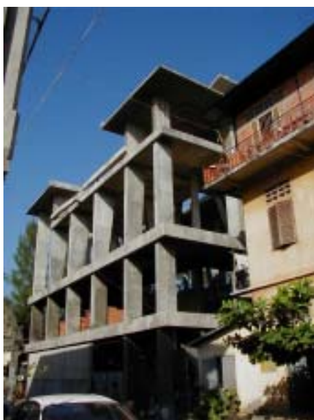
写真 プノンペンのウナローム寺院内に建設中の「ひろしまハウス」
